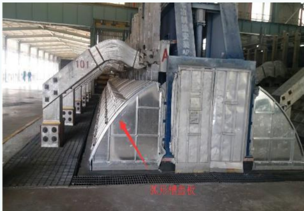
电解槽安装弧形槽盖板
