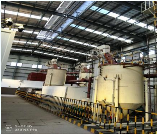
电解槽大修渣无害化处置项目
