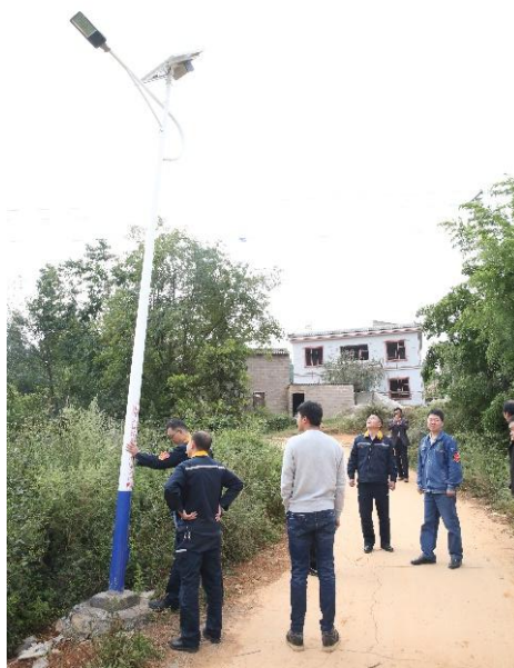
云铝涪鑫为磨嘎村安装太阳能路灯
