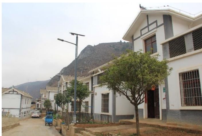
沈家沟村建设异地安置房
