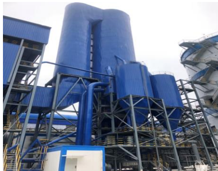
云铝海鑫电解铝烟气脱硫装置
