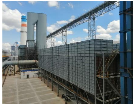
云铝文山电解铝烟气脱硫装置
